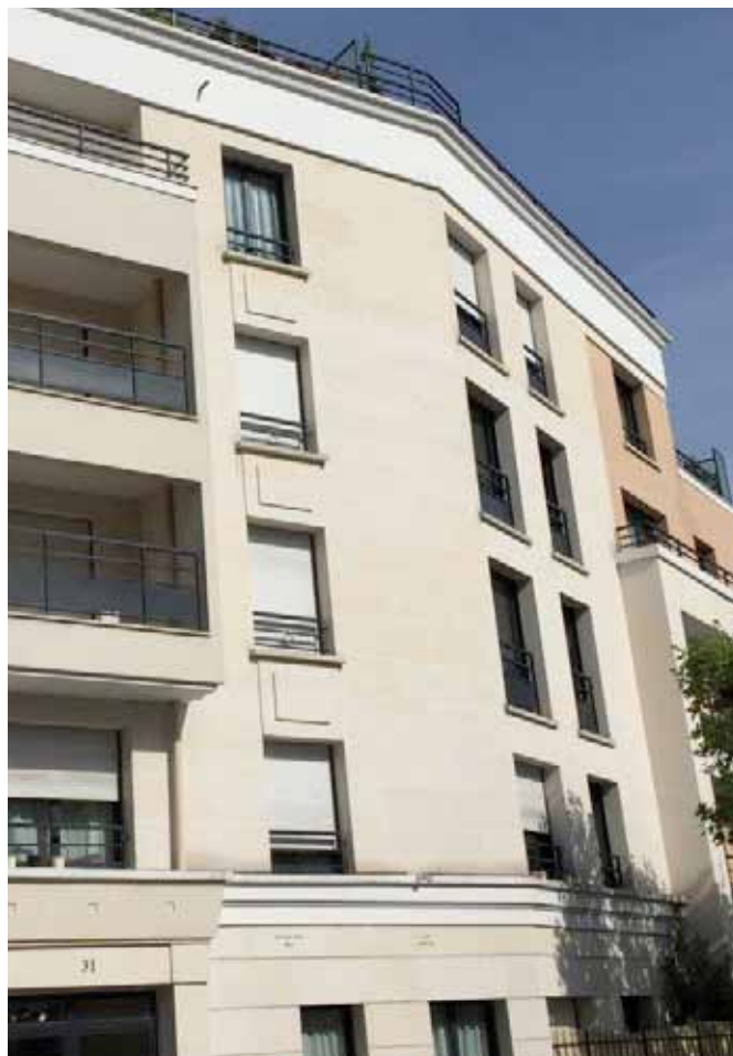
31-33, Boulevard du Maréchal Leclerc - Joinville-le-Pont (94) Domivalor 4
