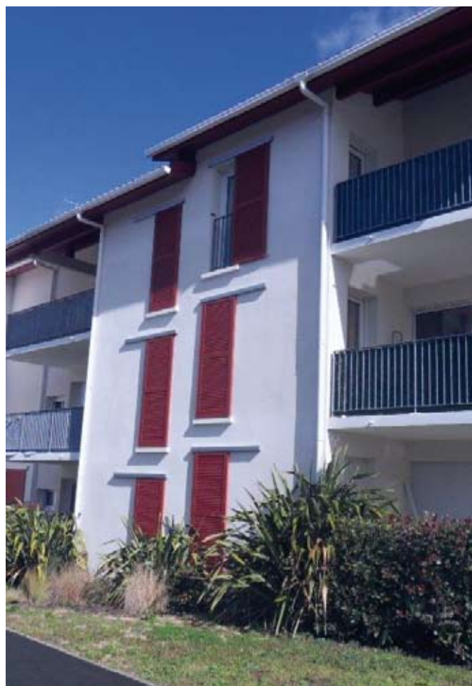
113, Côte de Loste - Saint-Pierre d'Irube (64) Domivalor 3
